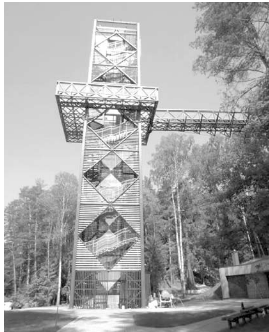
Pastačius pakabinamą pėsčiųjų tiltą, Medžių lajų taką lankytojams bus galima pasiekti dar patogiau.
